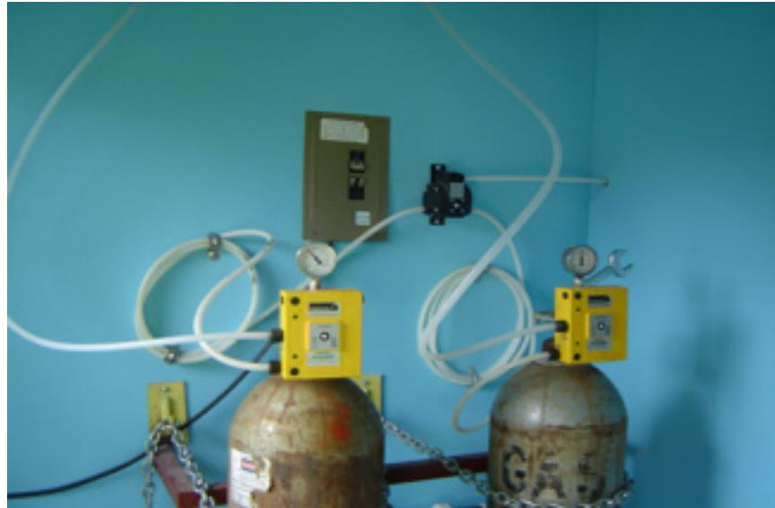
Los sistemas de desinfección deben instalarse en casetas bien ventiladas, amplias y de uso exclusivo para cloración. Las tuberías deben quedar a la vista, sujetas contra la pared y en lugares accesibles, que permitan su fácil inspección y reparación. El cloro gas cuando se mezcla con el agua es altamente corrosivo, por lo que se deben utilizar materiales tales como PVC, teflón, caucho, polietileno, entre otros.
